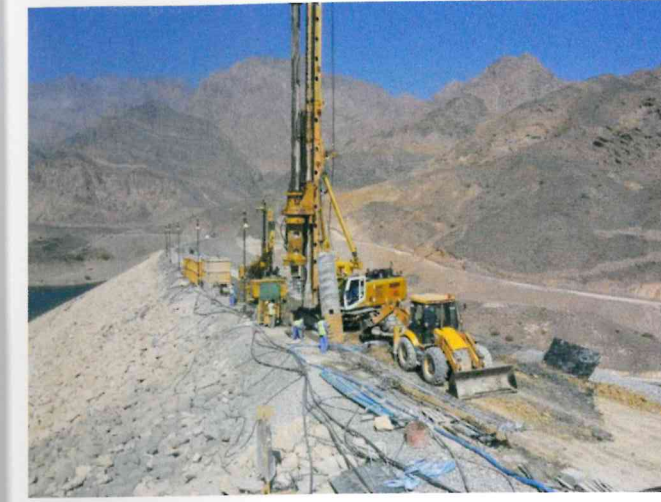
Fig. 8 Bored piling work to the side dam Bild 8 Bohrpflararbeiten am Seitendamm
