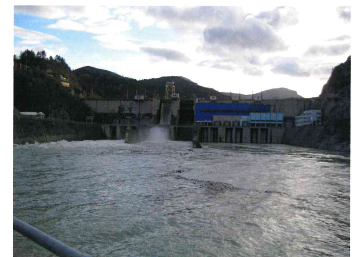
Fig. 3 Višegrad hydropower plant Bild 3 Kraftwerksanlage Višegrad
