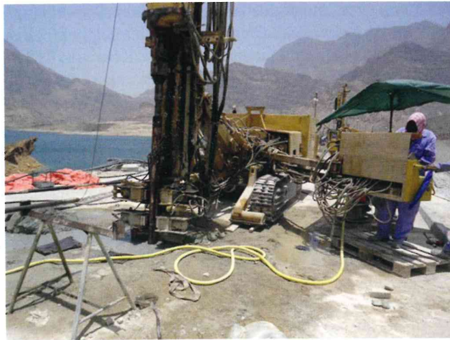
Fig. 7 Grouting works to the side dam Bild 7 Injektionsarbeiten am Seitendamm
