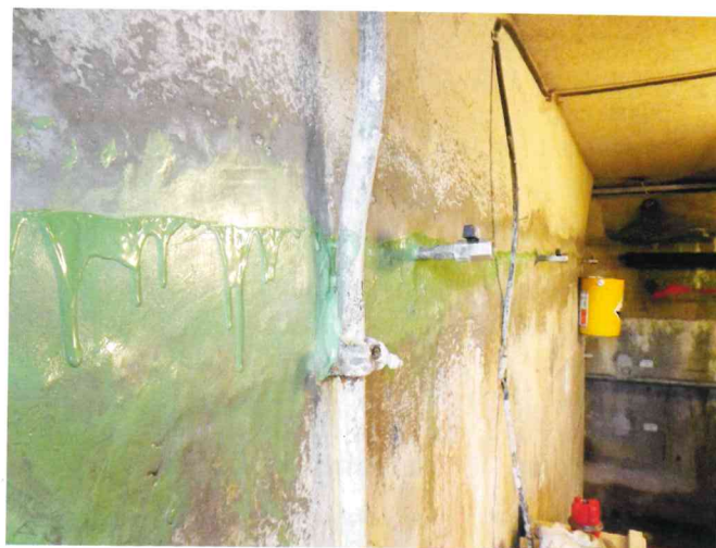
Fig. 16 Injection of the dry crack with synthetic resin Bild 16 Injektion des Dry Cracks mit Kunstharz
