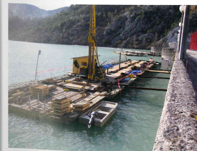
Fig. 5 Drilling platform on pontoons and core extraction with encountered karst cavities Bild 5 Bohrplattform auf Pontons und Kernprobeentnahme mit angetroffenen Karsthöhlräumen
