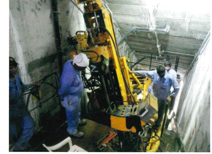
Fig. 9 Diamec 282 drill in the control passage of the dam Bild 9 Bohrgerät Diamec 282 im Kontrollgang der Sperre
